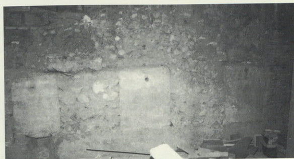
Merlets del parapet de la muralla conservats com a mitjanera en un habitatge del carrer Sant Llorenç.
