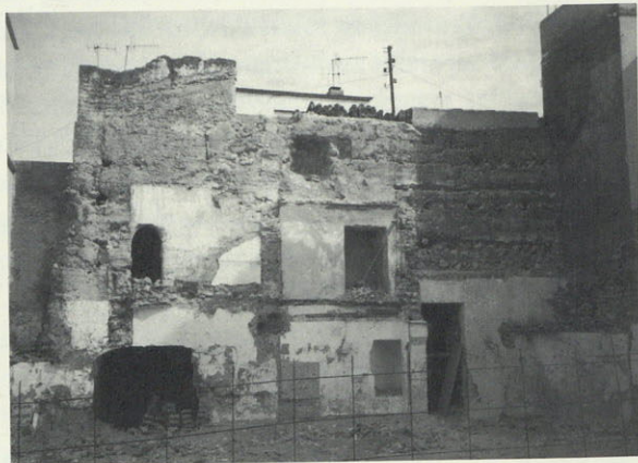
Vista interior de la muralla carrer Sant Cristòfol.
