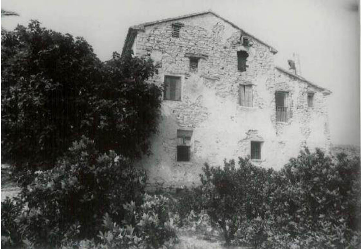
Imagen 18: Imagen del estado de la edificación. Fuente: Ficha IPCE (1979 en adelante).
