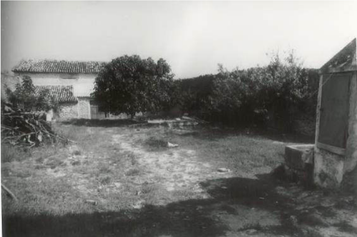
Imagen 14: Imagen del estado de la edificación. Fuente: Ficha IPCE (1979 en adelante)
