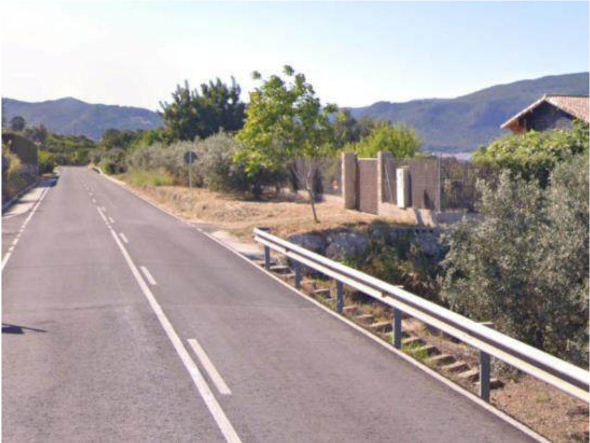
Imagen 113: Imagen carretera CV-715 en dirección a Pego. Fuente: Elaboración propia.
