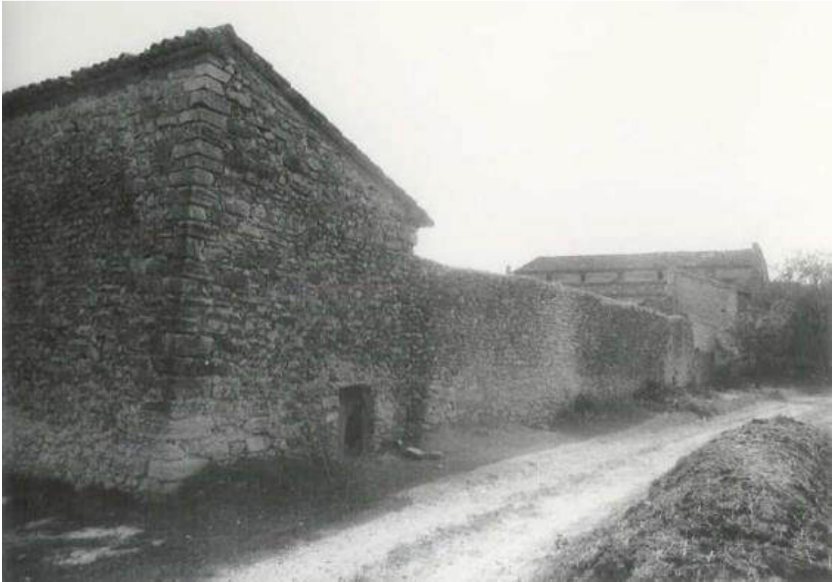
Imagen 19: Imagen del estado de la edificación. Fuente: Ficha IPCE (1979 en adelante).
