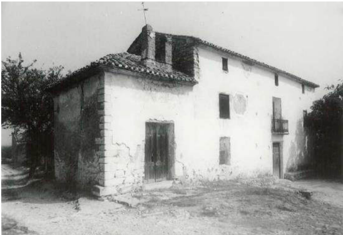
Imagen 13: Imagen del estado de la edificación. Fuente: Ficha IPCE (1979 en adelante)
