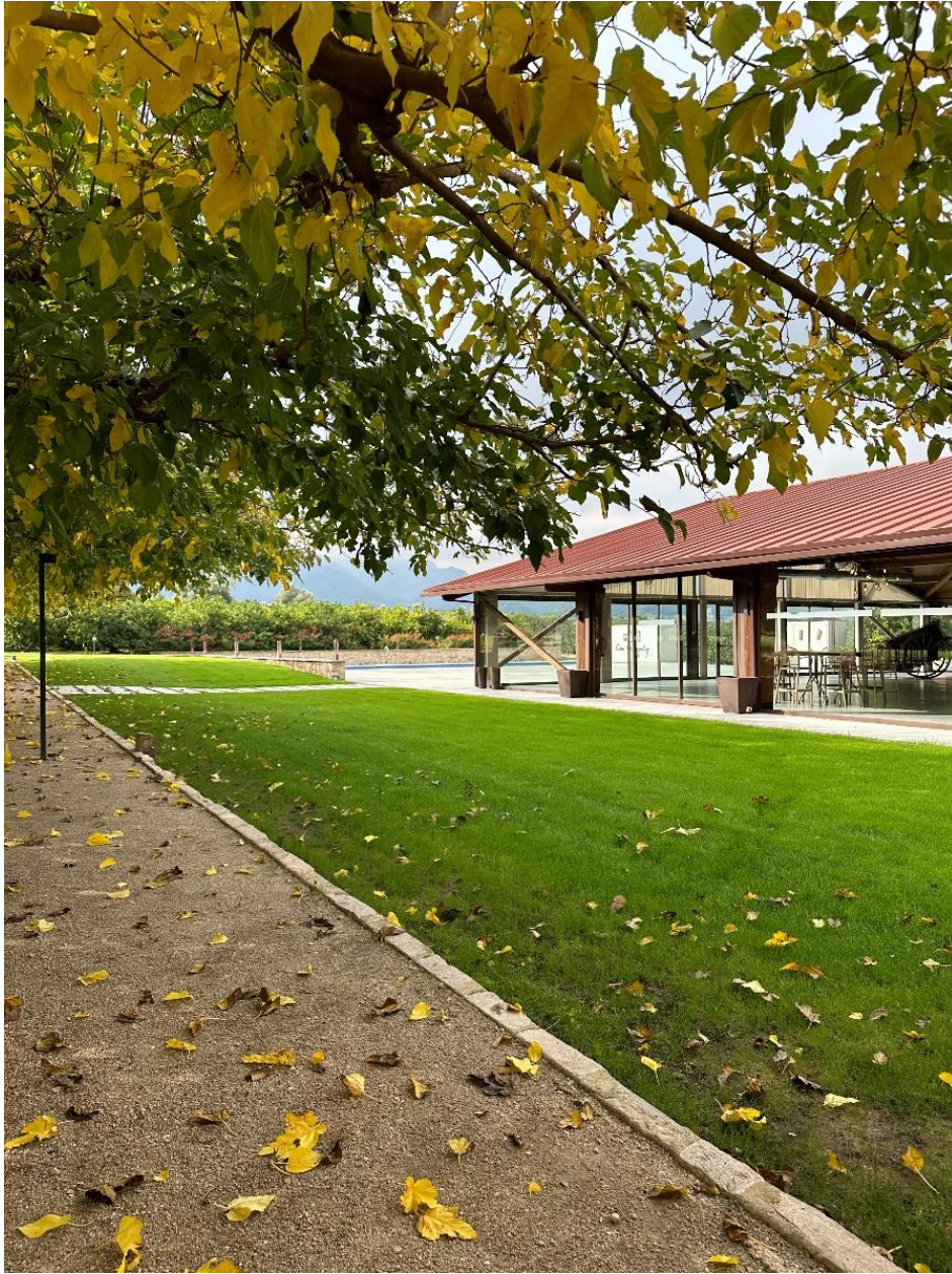
Imagen 2: Estado actual de la carpa. Fuente: Visita a campo.
