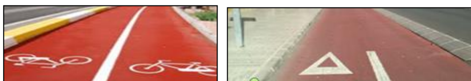
Imagen N°82.- Carril bici segregado en calzada.
