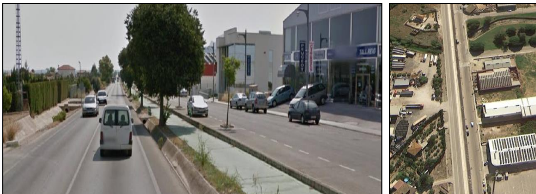
Imagen Nº25.- Imagen de carretera N-700 en zona de polígono industrial anexo a Pego
