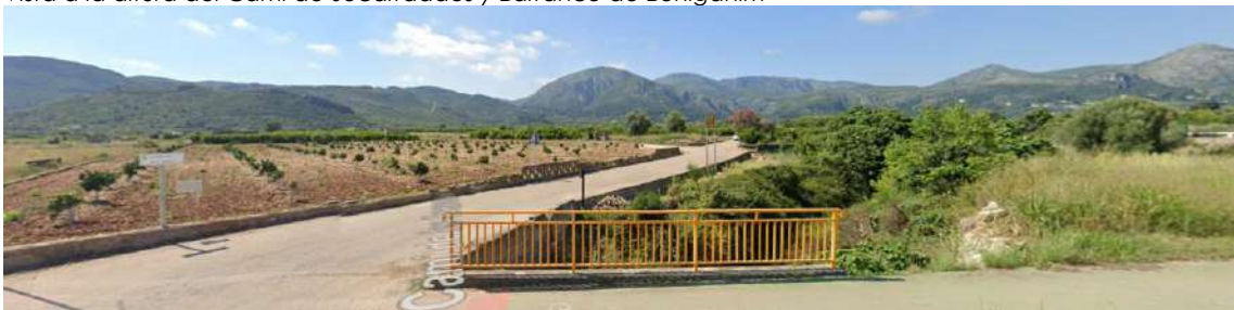
Vista a la altura del Camí de Socarradaes y Barranco de Beniganim
