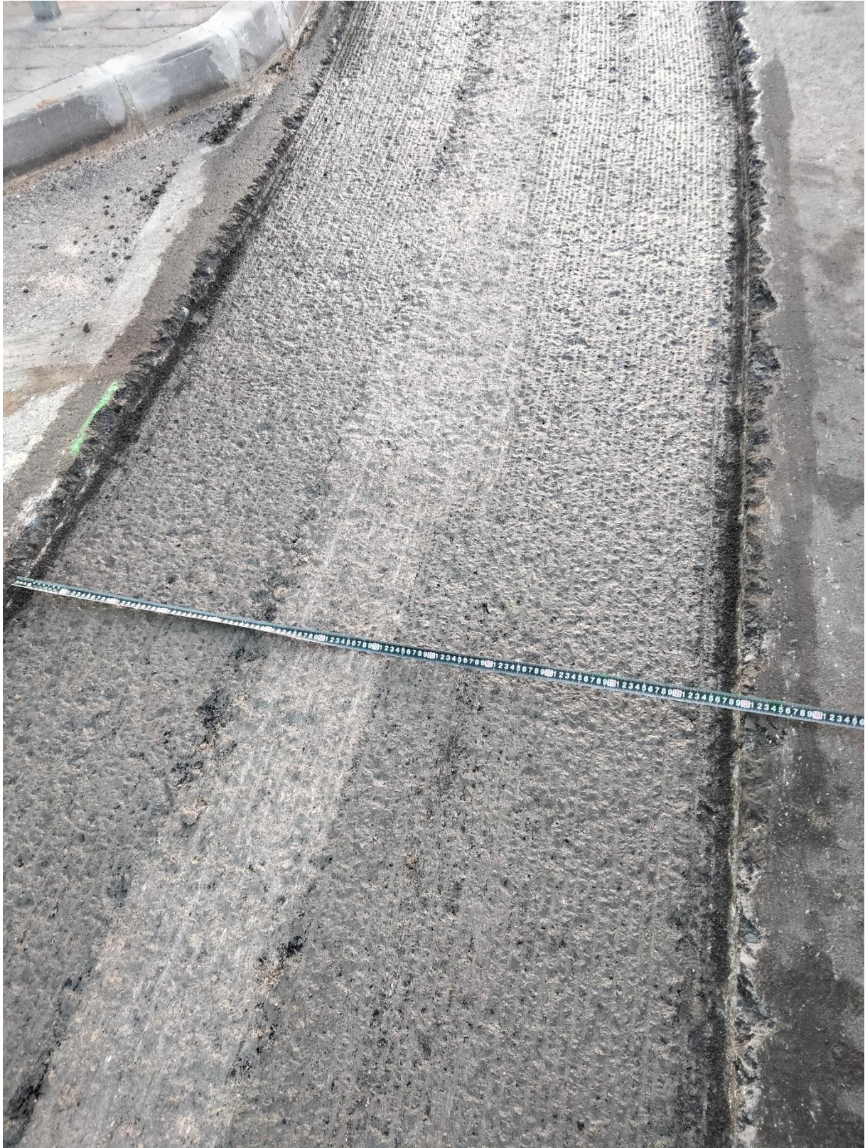
Obra civil fibra óptica.
