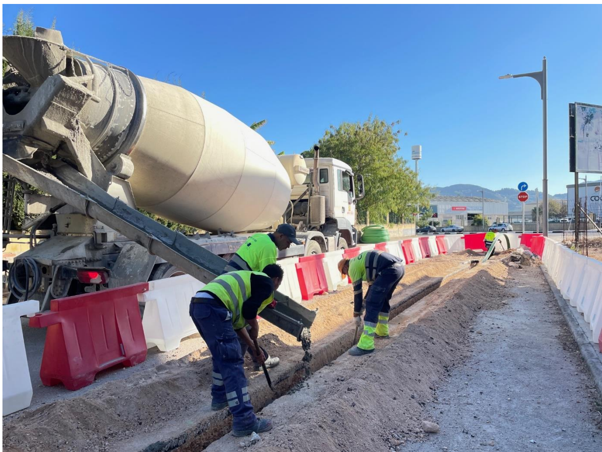
Obra civil fibra óptica.
