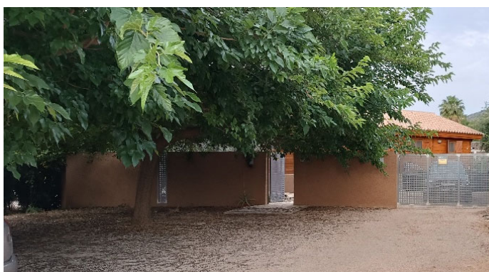
Ilustración 15: Fotografía del muro.
