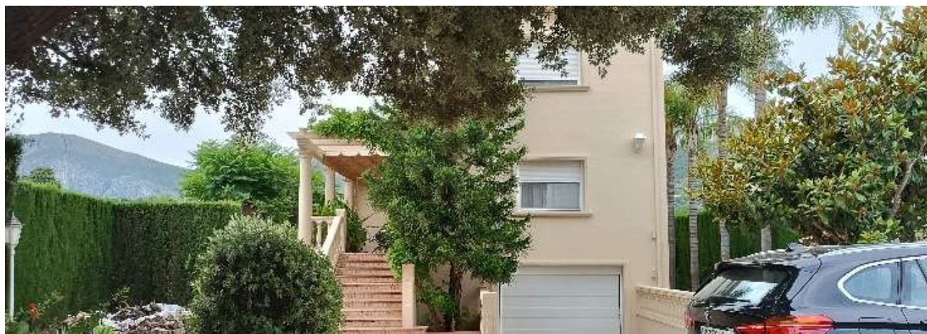
Imagen 4. Vista general de la vivienda existente.
