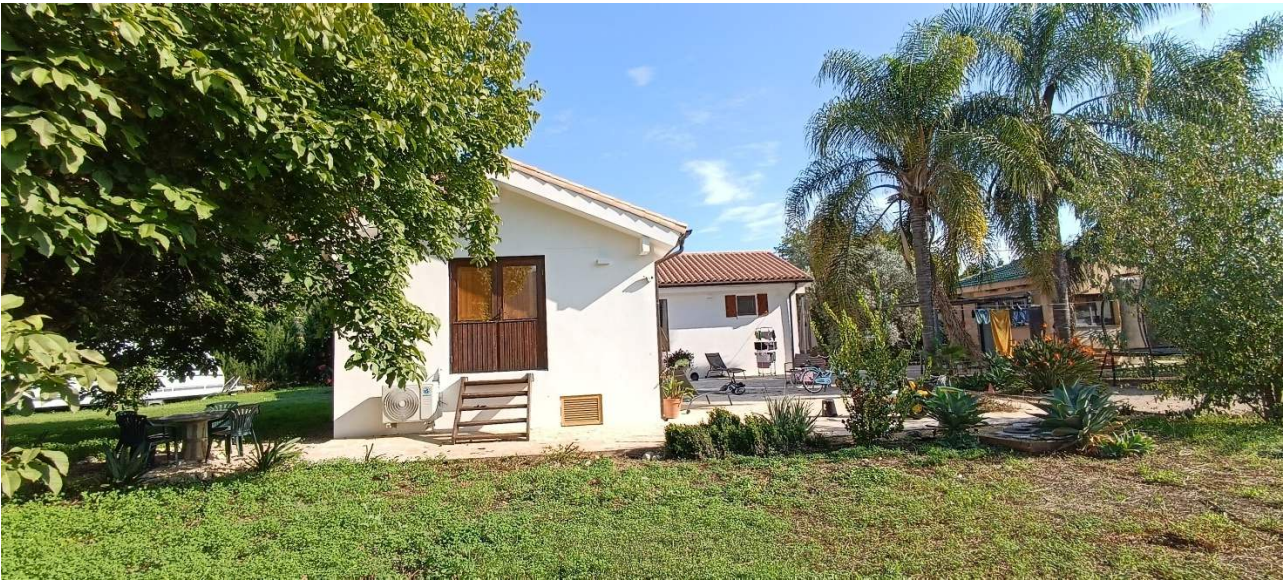
Imagen 4. Vista general de la vivienda existente.
