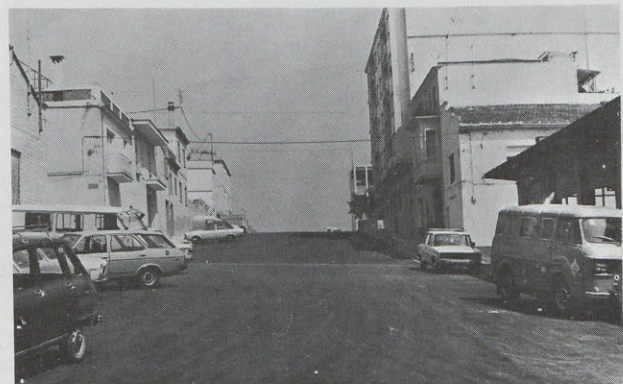
Aquesta es l'Avenguda de Fontilles una vegada les obres de pavimentació acabades.
