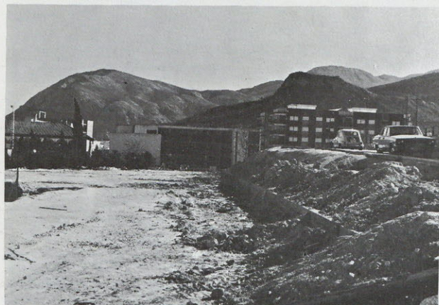
Emplazamiento de las obras de ampliación del Instituto y trabajos de cambio de trazado de la red de agua.
