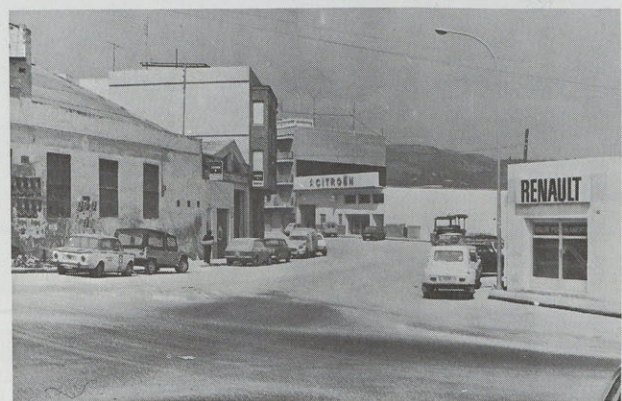
Nou aspecte de la "Avenida de Alcoy"
