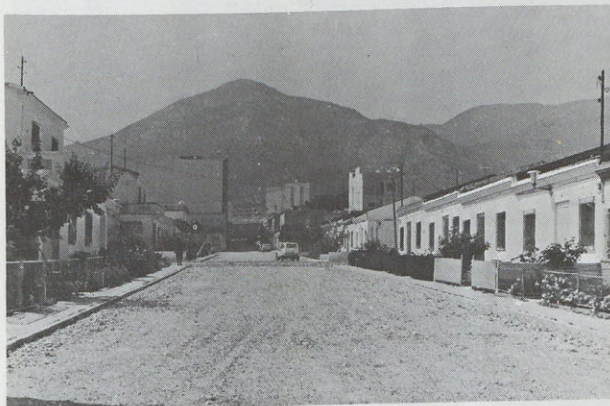
Pavimentació dels carrers de les Cases Barates.
